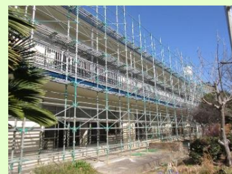
外壁工事 R5.3.1
